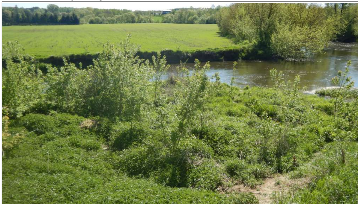
Widok na całe osuwisko z góry (maj, 2023)
