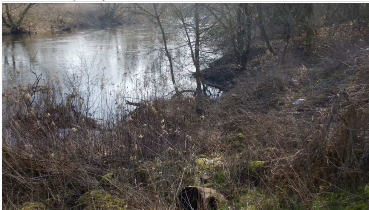
Widok (z góry) dolnej części osuwiska
