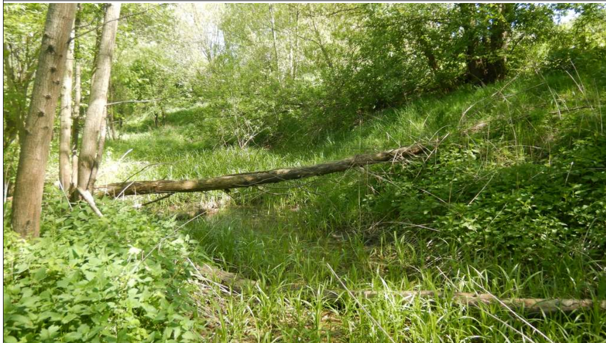
Odcinek płytkiego rowu osuwiskowego
