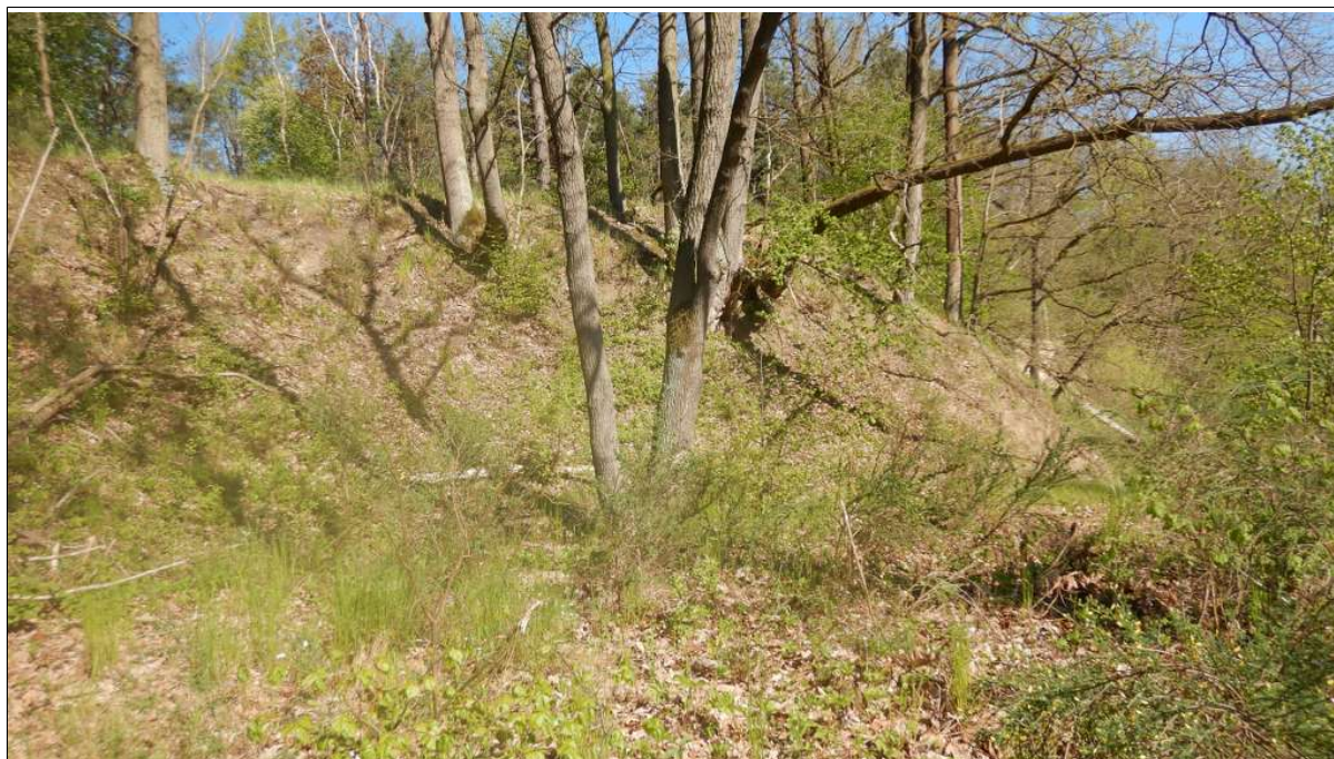
Skarpa główna osuwiska
