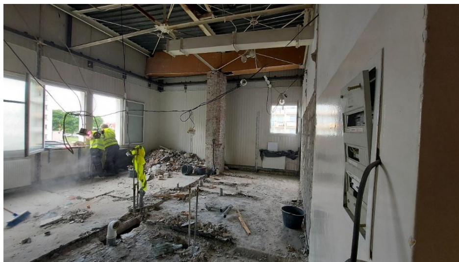
Fot. Widok prowadzonych prac
