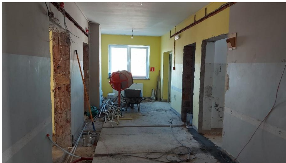
Fot. Widok prowadzonych prac w Domu Pomocy Społecznej „Dom Kombatanta” w Dobrzejewicach.
